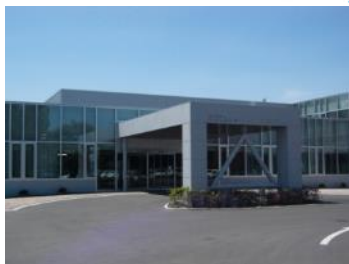
1号館正面玄関 (平成19年2月改修)
