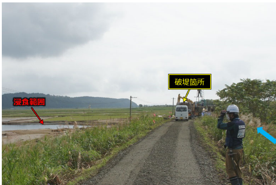
図 3.1 上流から撮影した破堤箇所付近の堤防天端の状況
