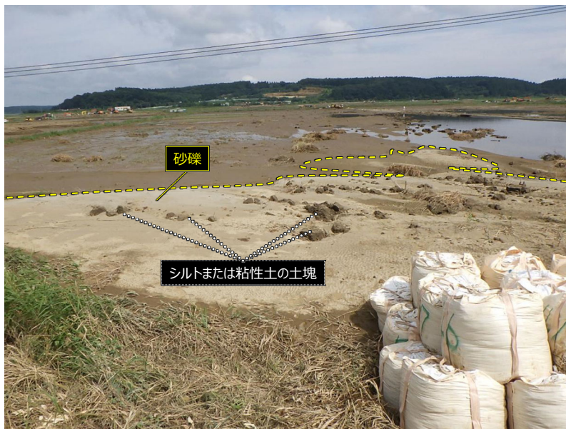
図 3.6 破堤口上流側における堤内地盤の土砂堆積状況
