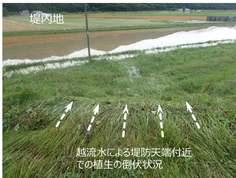
図 3.2 越水によって植生が倒伏した例
