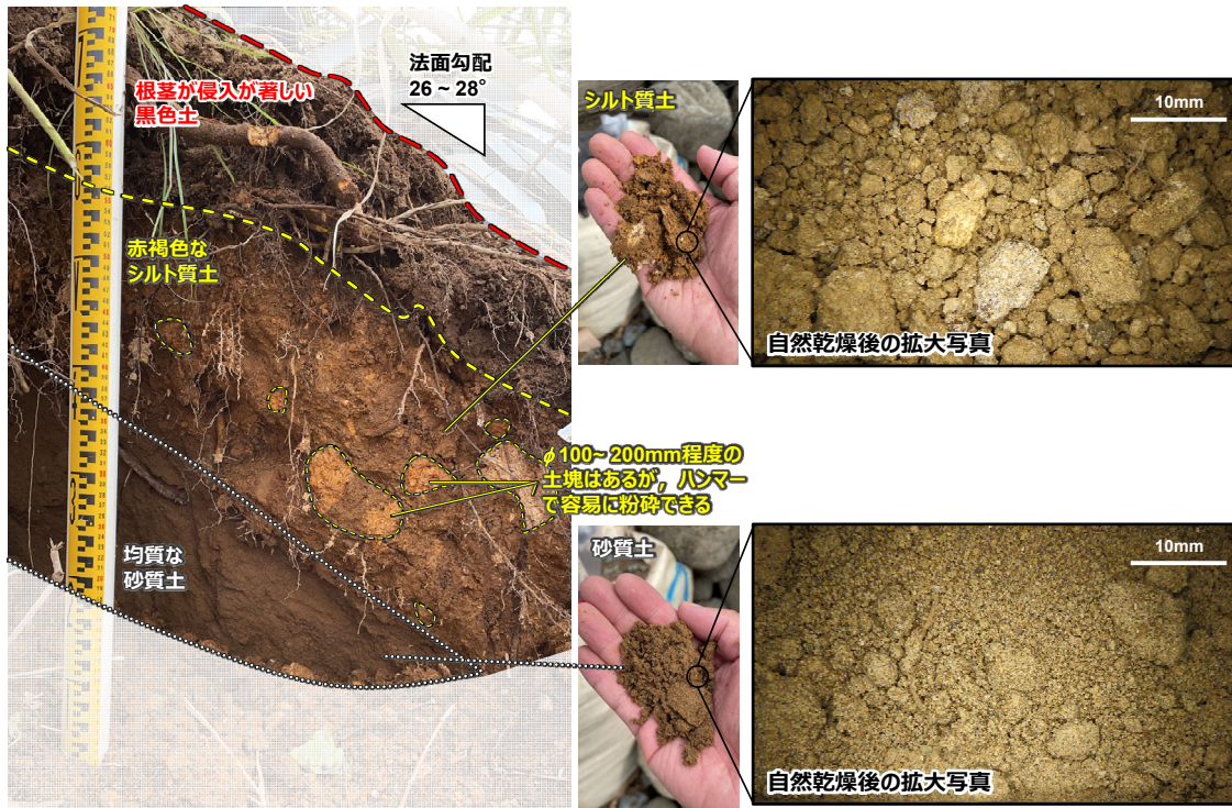
図 3.7 破堤によって撮影した堤内地盤の浸食状況
