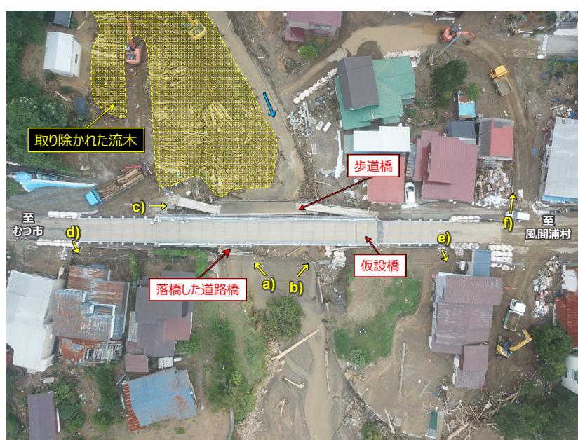
図 3.8 被災橋梁直上から撮影した被災状況
