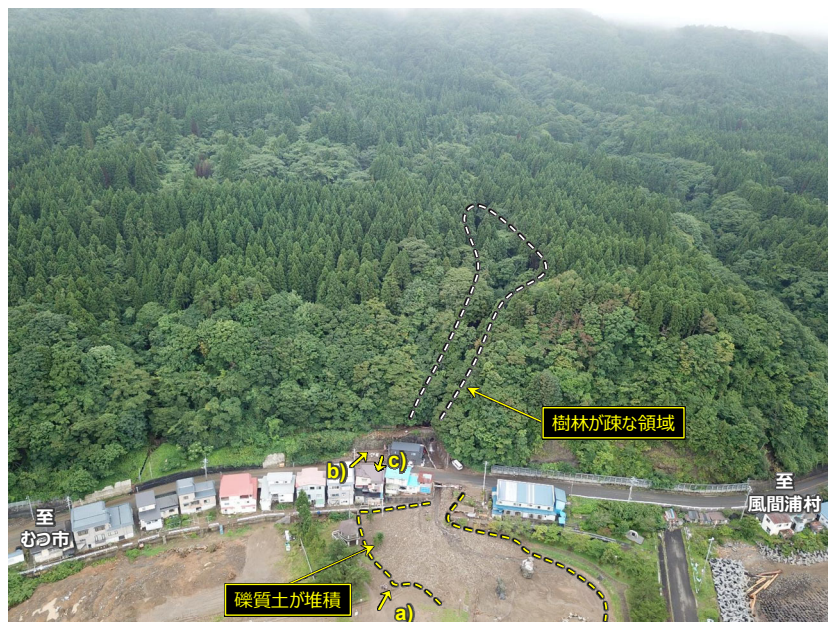
図 3.19 斜面崩壊③による被災か箇所の全景
