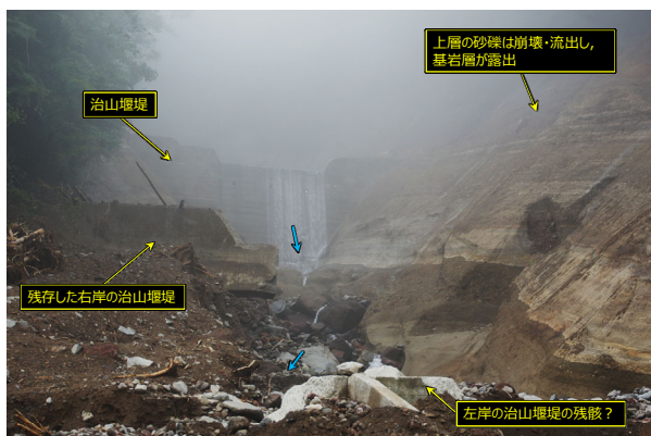
図 3.16 崩壊斜面および治山堰堤の状況
