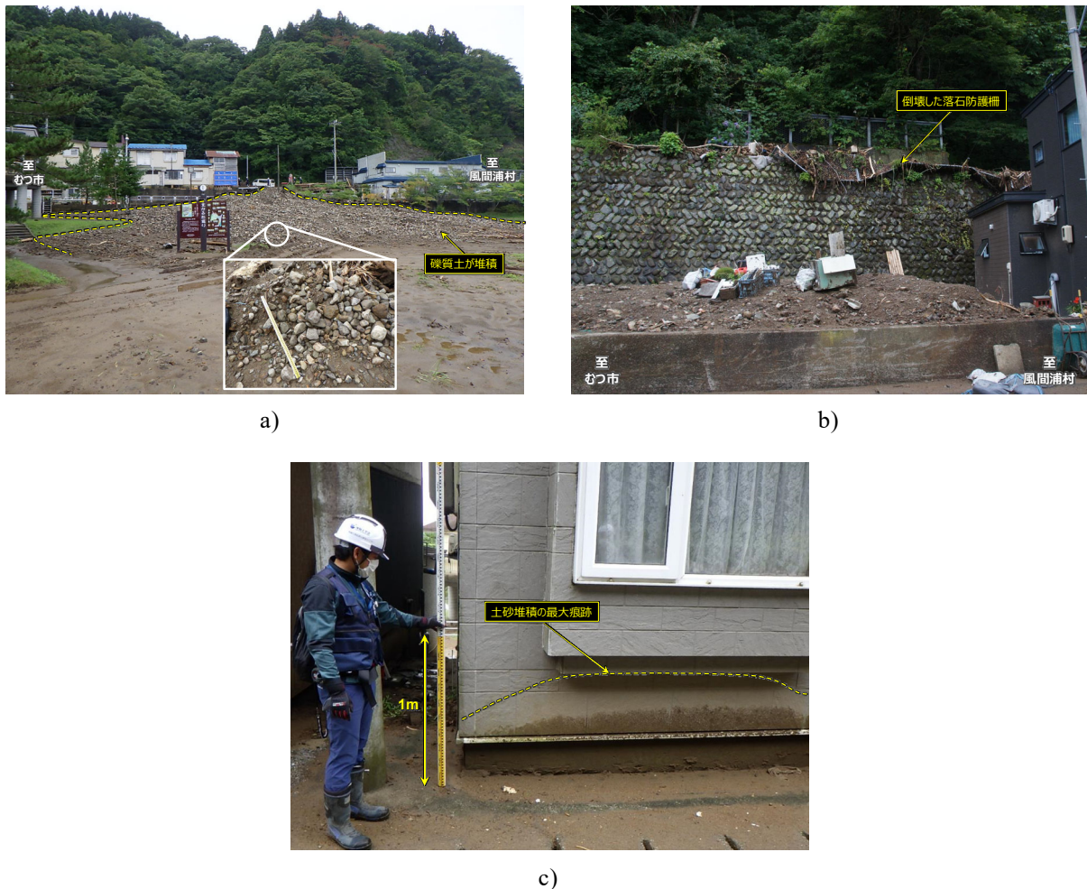
図 3.20 斜面崩壊③における被災箇所状況
