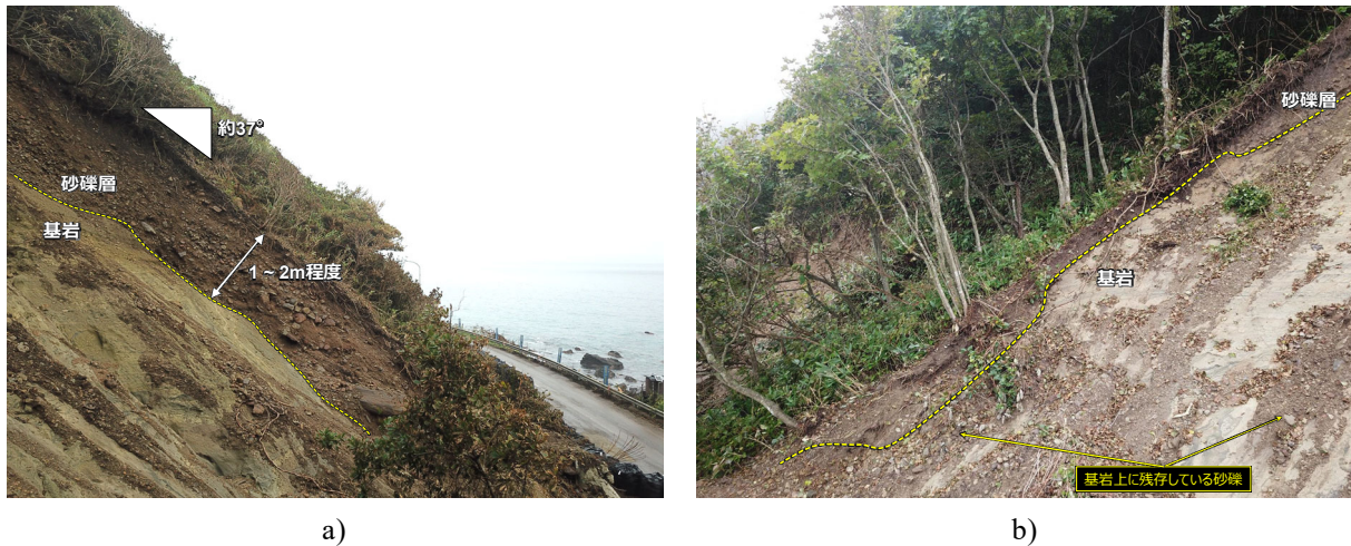
図 3.14 斜面崩壊①における崩壊面の状況
