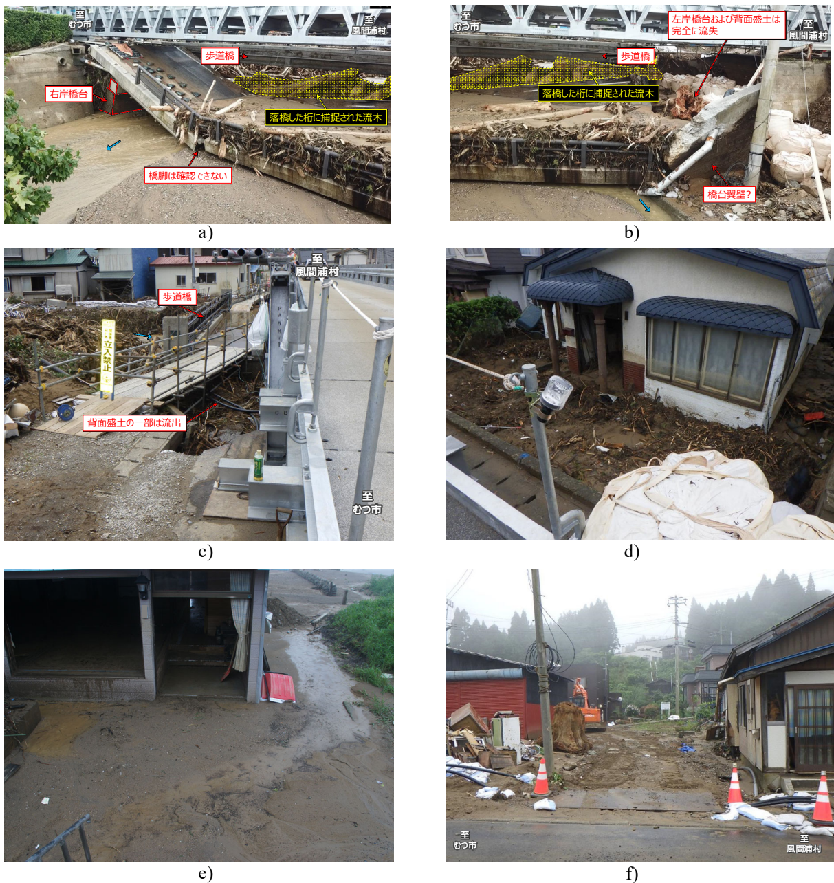
図 3.9 被災箇所周辺の地盤被災の状況
