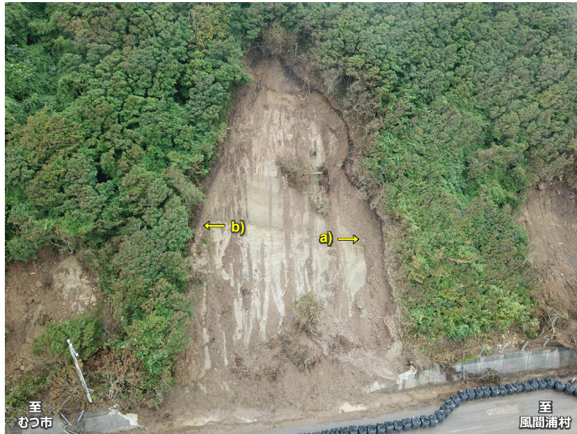
図 3.13 斜面崩壊①の全景
