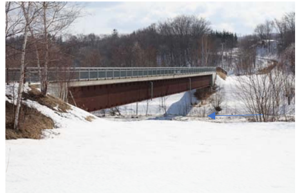
達美橋 (左岸側から撮影, 橋脚は低水路に無し)
