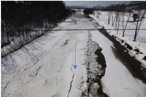
活汲橋上流 (橋から撮影)
