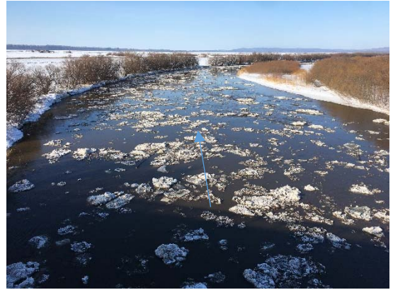
湖響橋下流（橋から撮影）
