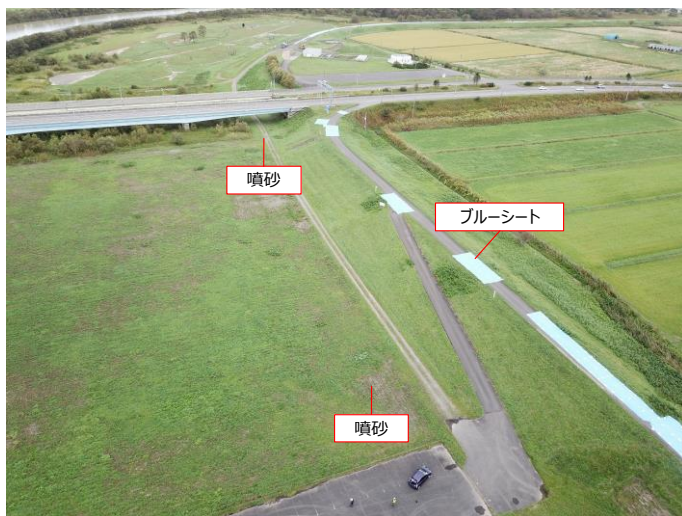
図 5.2d) ブルーシートによる応急対策 (KP2.5 付近)
