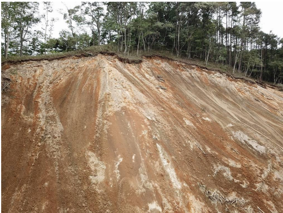
図 4.4d) 図 4.3 中の d)付近からの崩壊面付近の状況
