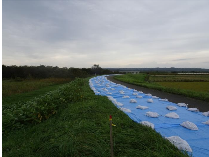
図 5.2c) ブルーシートによる応急対策 (KP3.5 付近)
