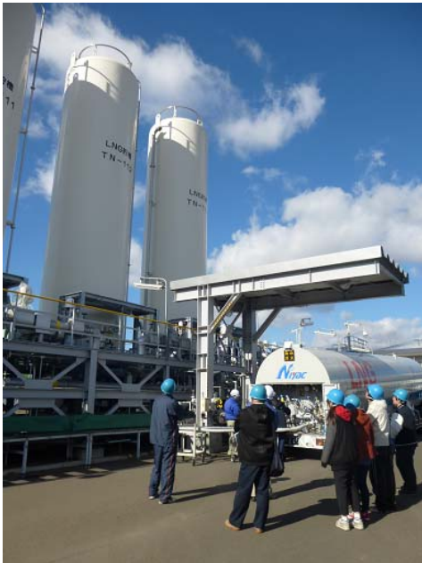
トレーラー車からLNGタンクへの注入作業
