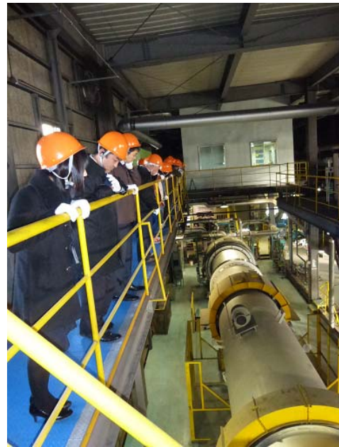
使用済み乾電池の焙焼炉(ロータリーキルン)
